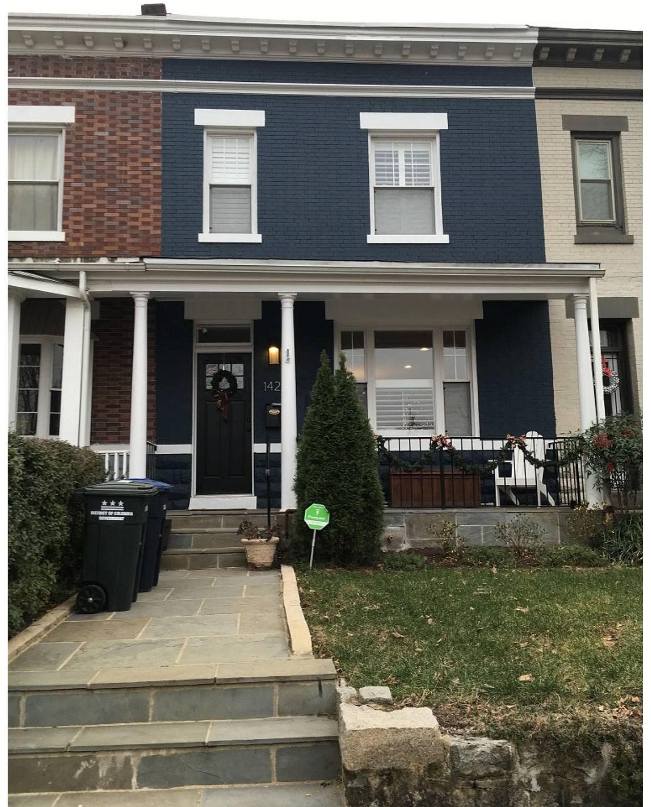
1 FRONT FAÇADE OF 1421 D STREET SE C-4 SCALE:N.T.S.
